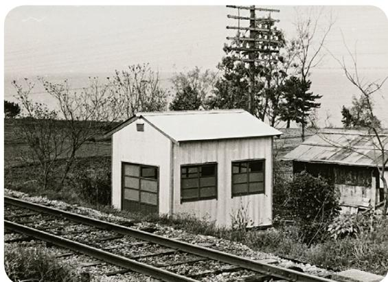
創業商品「パイプハウス」。高度経済成長期、国鉄(現JR)などに採用された。プレハブ方式で「建築の工業化」を追求した
