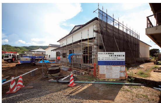
2012年●一関市の廃校になった小学校跡地にしょうゆ工場を建設中で、10月に完成予定だ。現在も「八木澤商店しょうゆ醸造ファンド」で資金を集めている
