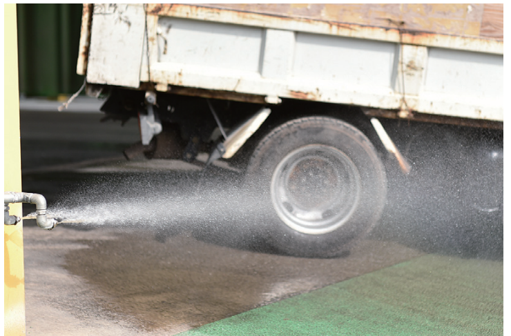
産廃を運ぶトラックが敷地を出るとき、タイヤを自動洗浄する。近隣に塵埃が飛ぶのを防ぐ環境対策だ
